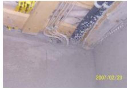
\* Kabeldurchführung für den Außentemperaturfühler der WP - Heizung
